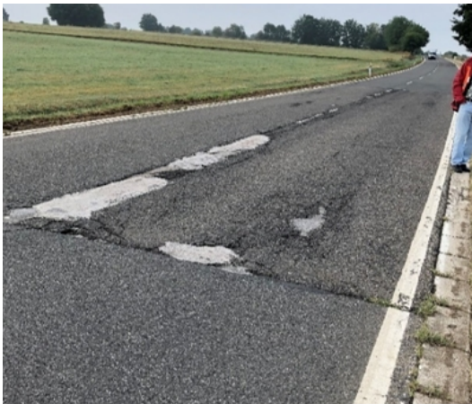
Abbildung 4: Fahrbahn, Schadstelle mit Ausbrüchen und Spurrillen
