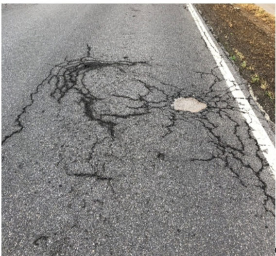
Abbildung 6: Ausbrüche und Risse
