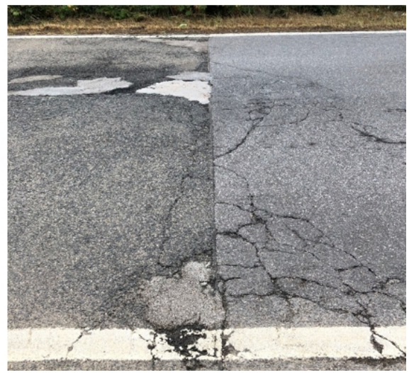
Abbildung 7: Schadstelle am Übergang unterschiedlicher Deckschichten
